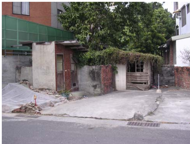
↑ 台南市北區三德里公園南路233巷38號旁路邊廢棄建物現況
